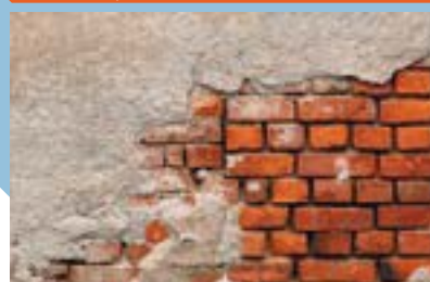
Foraj în zidărie solidă
